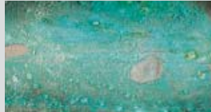
BIRIKINTI KOROZYONU Yetersiz su arıtmasından kaynaklanan yosun ve çamur birikintisi.
