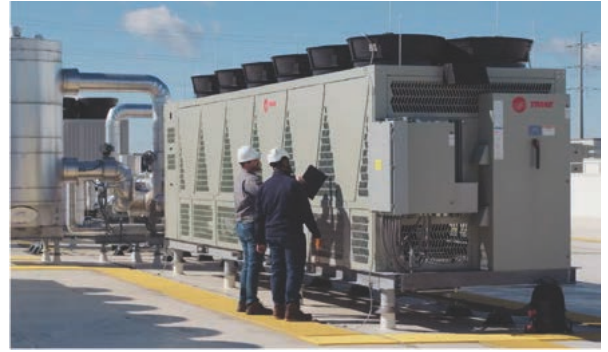
Enfriadora Trane TCAA de condensación por aire, sin aceite y con rodamientos magnéticos
