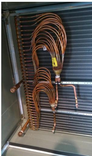
*Figura 2 – Modulo evaporador sem as tampas para acesso à linha de liquido.*
