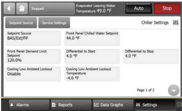
Figura 34. Tela de configuração do equipamento (configuração do chiller mostrada)
