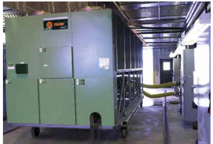
Facilidades de testes en el local de instalación aseguran la confiabilidad y la verificación del desempeño
