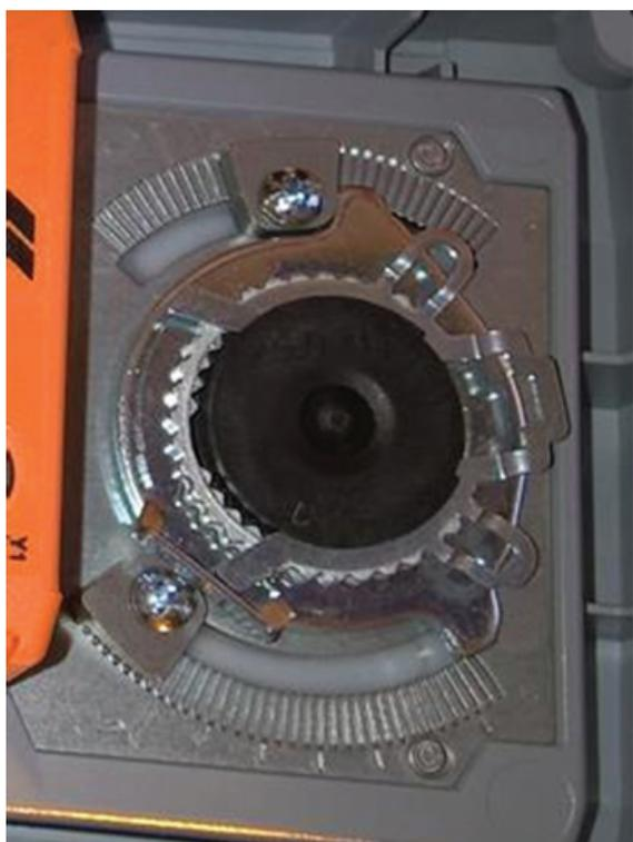
Se l'apertura minima viene modificata dopo la prima accensione, occorre ripetere la taratura del motore per confermare il nuovo intervallo di funzionamento. A motore acceso premere il pulsante LED verde (2). Il motore memorizza il nuovo valore di posizione del finecorsa sul relativo segnale (2-10 VCC).
