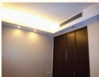
空调末端：风机盘管，气流均匀
