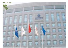
成都-四川省中国移动大楼
