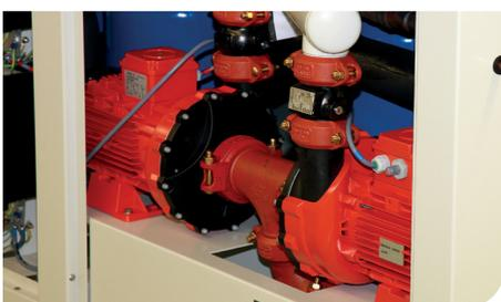
Le kit hydraulique intégré est doté de tous les composants nécessaires : pompes d'évaporateur et de condenseur, réservoir-tampon, et filtres à eau faciles à démonter.
