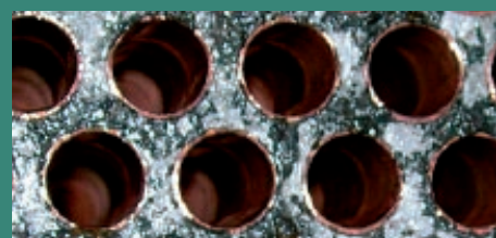
Tube après le nettoyage
