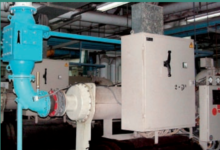
Système de nettoyage des tubes installé sur le refroidisseur CVGD de Trane
