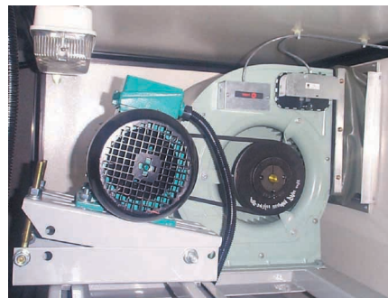
▲ 安裝於 CLCP 內的風車組件
