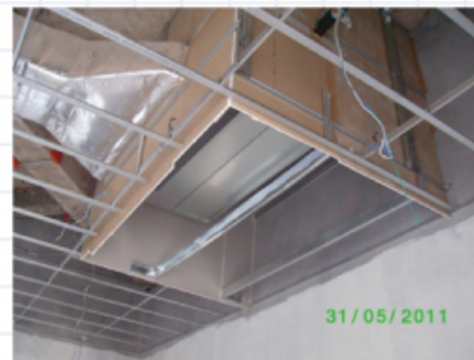
➔ การแสดงให้เห็น ยิบซั่มกล่อง Return Air Chamber ที่ติดตั้งให้ต่ำกว่า ฟ้าเพดาน
