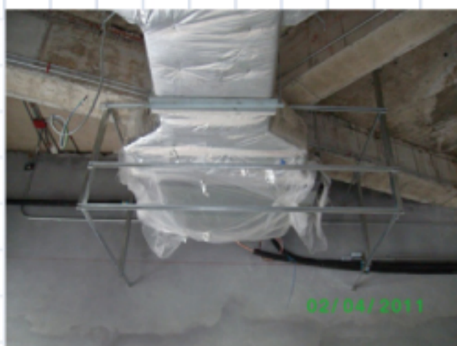
➔ เริ่มติดตั้ง โครงคร่าวกล่อง Return Air Chamber
