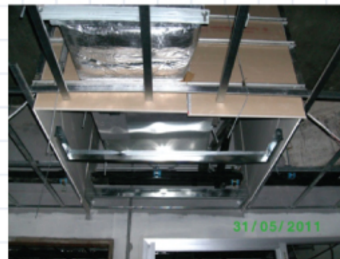
➔ การติดตั้งโครงฟ้าเพดานมารอบตัว Return Air Chamber
