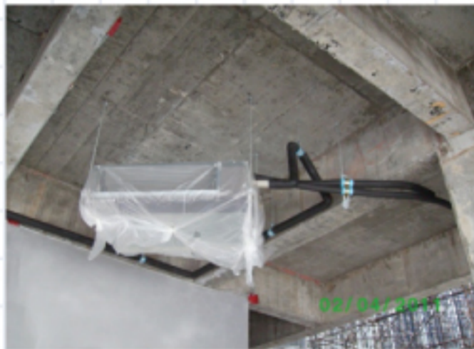
➔ การติดตั้ง FCU
