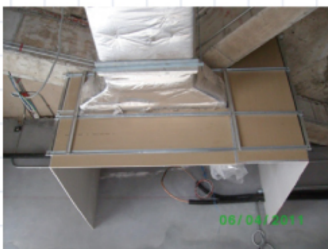
➔ การปิดแผ่นยิบซัมเพื่อทำ Return Air Chamber ก่อนติดตั้งฟ้าเพดาน
