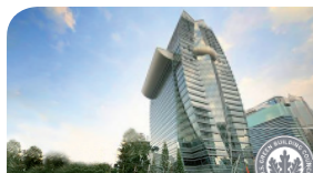
Park Ventures Ecoplex LEED ระดับแพลatinum ประเภทอาคารเฉพาะพื้นที่และเปลือกอาคาร ปี 2012
