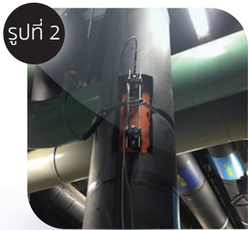
รูปที่ 2 อุปกรณ์วัดอัตราการไหล (Ultrasonic Flow Meter)
