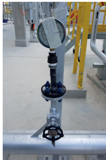
รูปที่ 1 : แสดงการติดตั้งมาตรวัดความดันสำหรับการทดสอบที่ 19.5 บาร์
