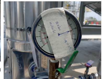
รูปที่ 2 : แสดงการติดตั้งมาตรวัดความดันสำหรับการทดสอบที่ 12.0 บาร์
